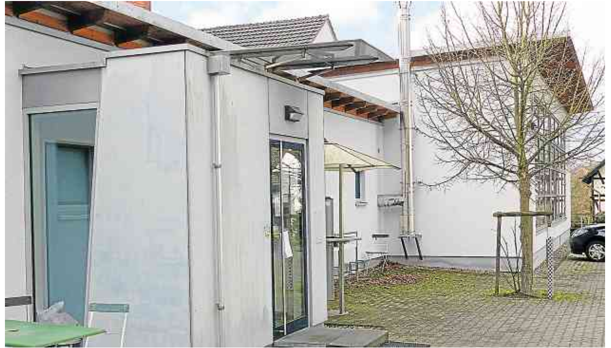
So sieht der Sportpark Niederberg seit der Generalsanierung und Erweiterung im Jahr 2003 aus.
